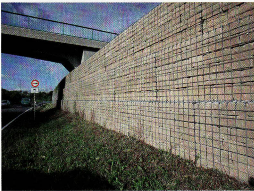
Der Gesamtaufbau besteht aus drei Lagen Santuro-Gabionen, die mit jeweils 15 Zentimetern Rücksprung aufgesetzt wurden.
