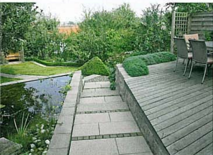
Stufen mit bossierten Stirnseiten gleichen in unregelmäßigen Abständen das Gefälle des Weges aus. Fotos: www.braun-steine.de
