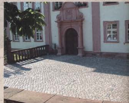
Die stilgerechte Pflasterung des Schlosshofes setzt einen vorläufigen Höhepunkt bei der Renovierung und Instandhaltung des Anwesens.
