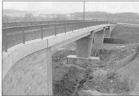
Die Widerlagerflügel dieser Brücke zur Überführung eines Wirtschaftsweges wurden mit Santuro-Spaltsteinmauern verblendet. Fotos: Santuro
