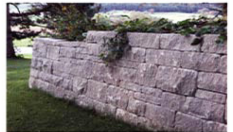
Die Mauern wurden trocken errichtet und sind von vergleichbaren Bauwerken aus Naturstein kaum zu unterscheiden. Verschiedene Formate ermöglichen ein lebhaft ineinandergreifendes Gefüge der Lagen.
